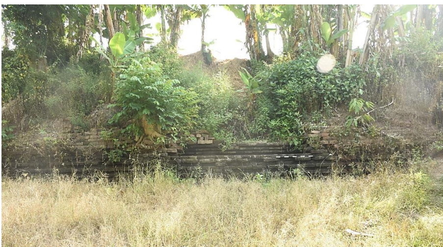
Gambar 6. Struktur saluran air yang terbuat dari bata di Desa Bulusari, Kec. Gempol, Kab. Pasuruan
